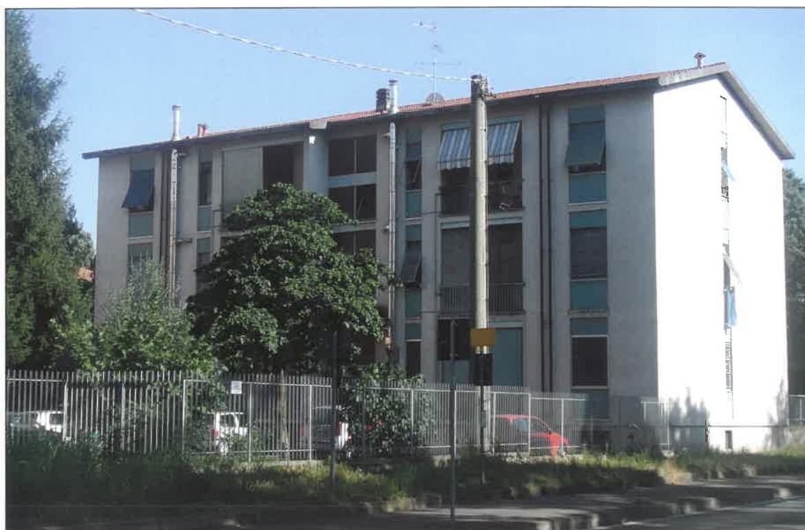
Un palazzo nel primo lotto di abitazioni costruito da Don Nemesio in via Monte Grappa.
