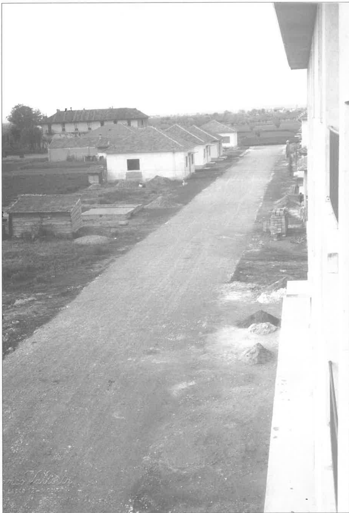
Visione di via S. Francesco dal terzo piano delle case Fanfani: la striscia di ghiaia della massicciata viene progressivamente affiancata dalle villette.
